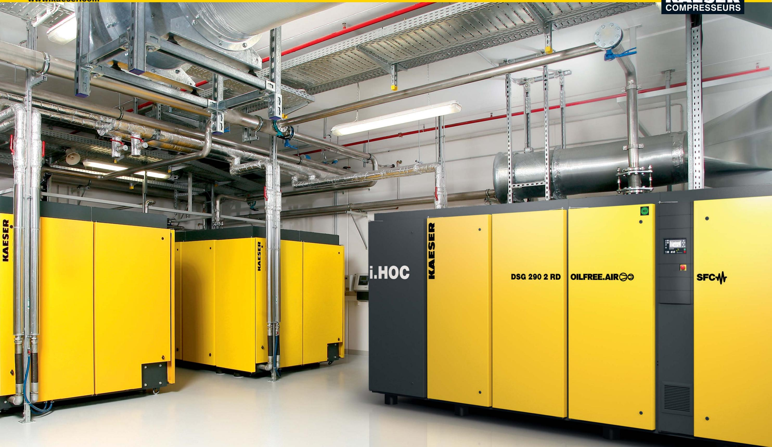
Photo : Exemple de station KAESER équipée d'un compresseur à vis sèches DSG 290-2 RD
